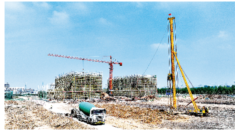
生物医药产业园建设现场。记者 徐松 摄
