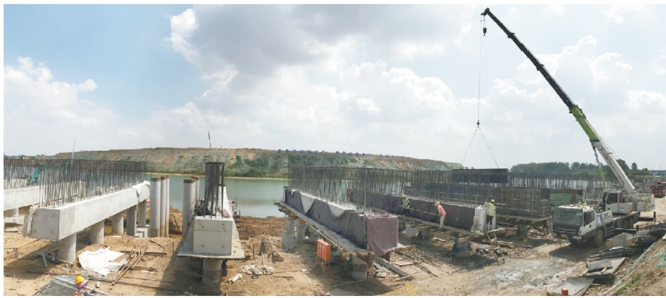
今年以来,沈丘坚持“产业强县、工业强县”,统筹疫情防控和经济发展,高位谋划,集群化发展钢铁企业,着力推动钢铁企业延链、补链、强链,实现钢、港、产、园、城深度融合的临港经济发展新模式,打造豫东南皖西北最大的港口物流流域,一座现代化“钢铁新城”在建设中的周钢码头。 记者 高洪驰 摄
